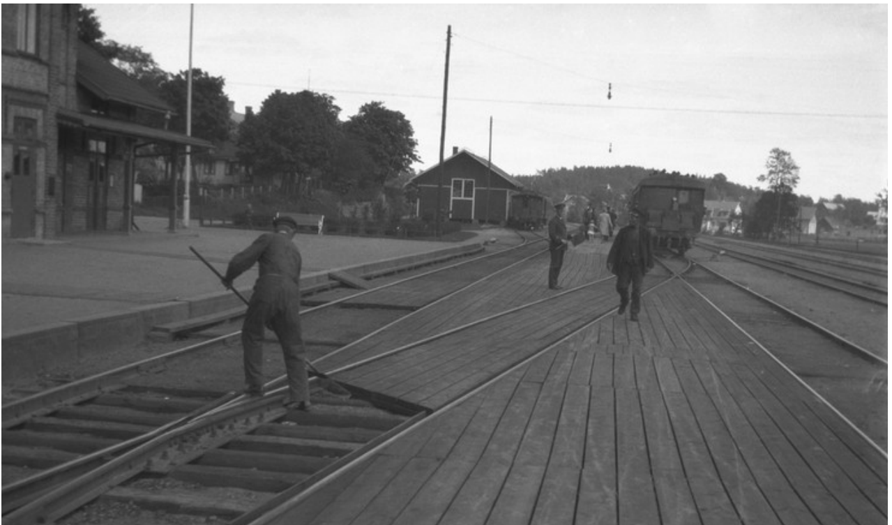
I mitten skymtar godsmagasinet. Här syns hur avdelande lister och foder tidigare varit vitmålade.
