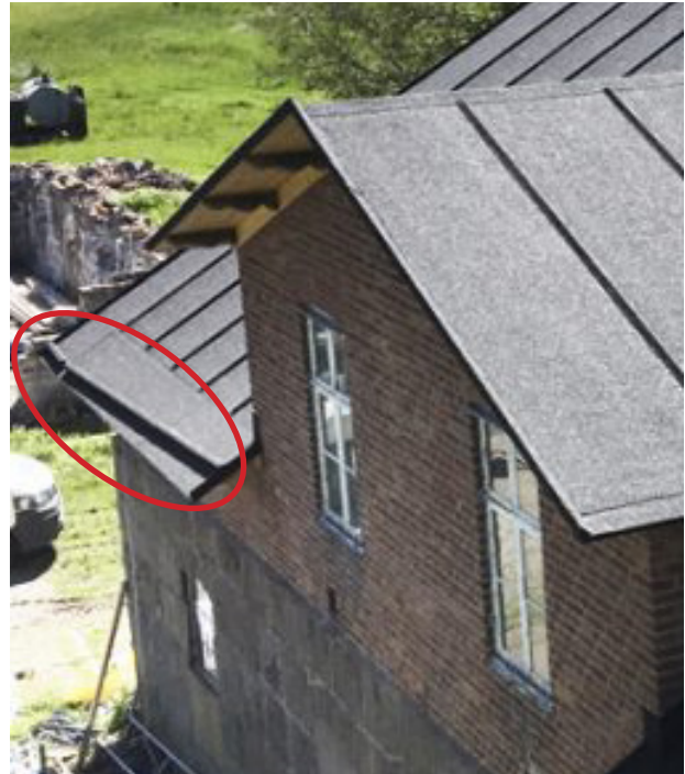
Exempel på stådränna vid papptak, se röd markering.
